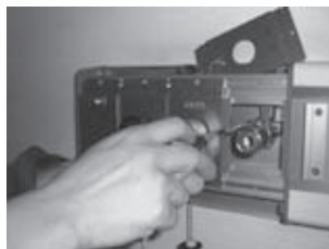
酸素漏れの応急処置
