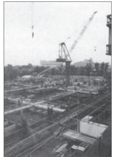
昭和62年10月ごろ 建築中の新病棟 右上のベランダは旧西病棟
