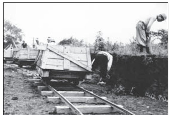
整地工事中の敷地
