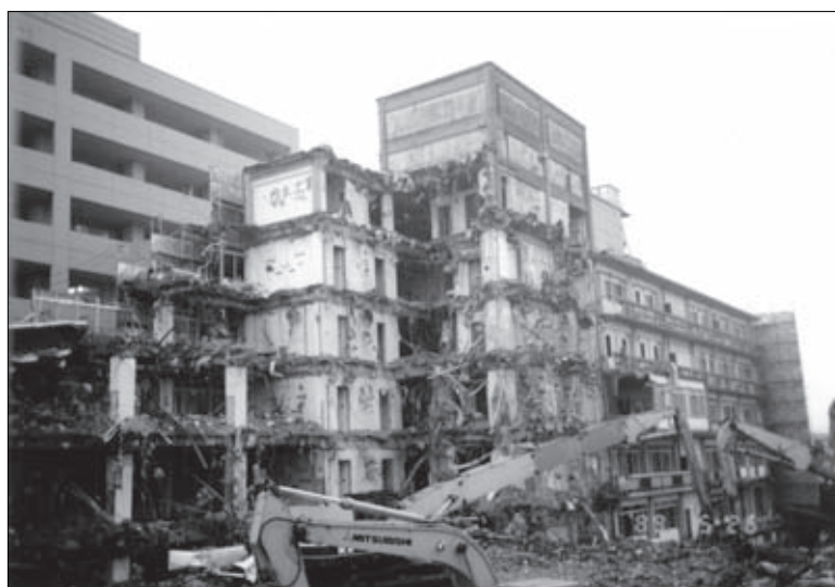
平成元年5月 旧西病棟の解体工事がはじまった
